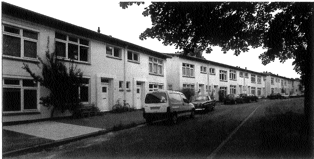
De Ravelijn, geel geschilderde A-woningen aan de Ravelijnstraat na de renovatie eind 20e eeuw. Foto: Rijksdienst voor de Monumentenzorg, K. Roderburg, 2001.
